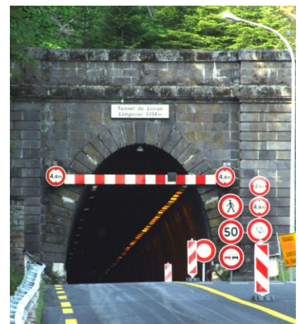
Premier tunnel routier
